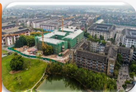
成都学院扩建工程
